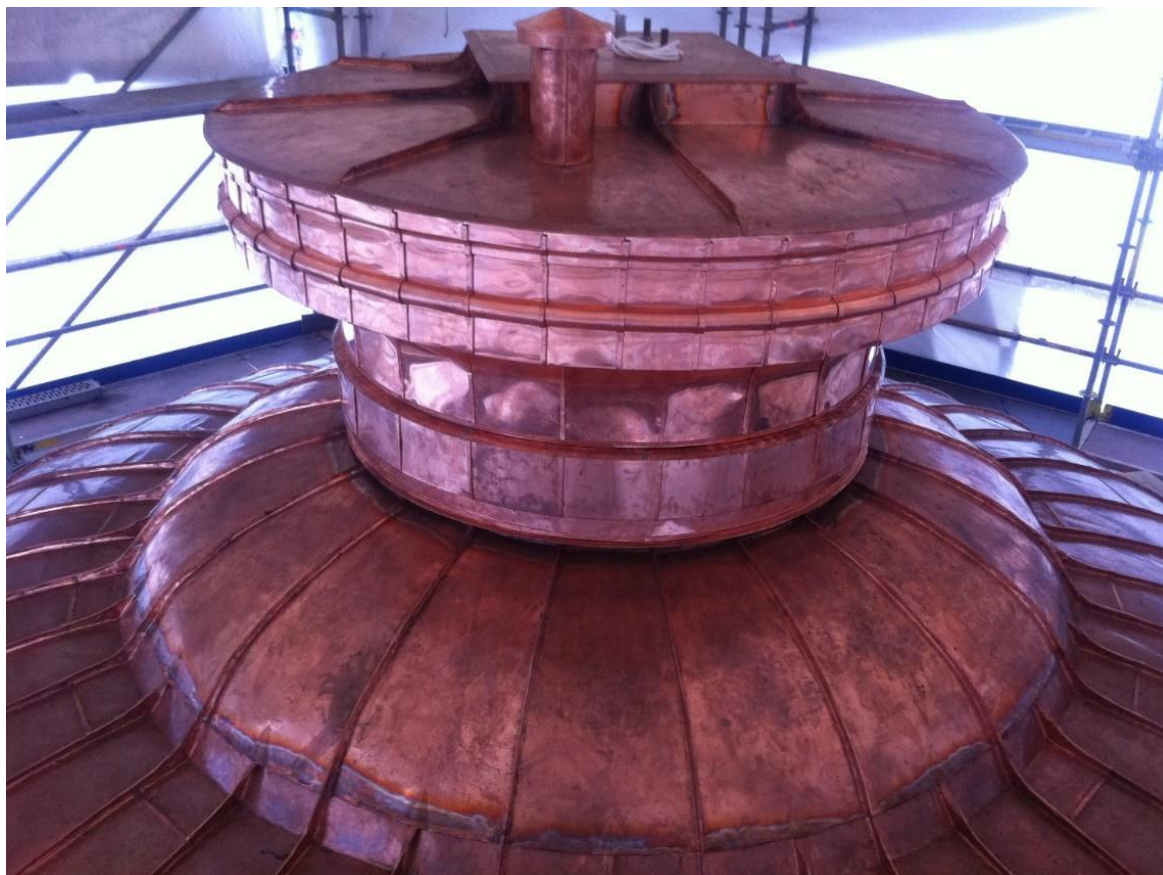
Færdigt kobberarbejde inden gelænder bliver monteret.
